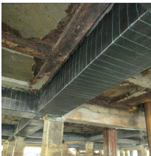
Gia cường, bảo vệ kết cấu (vật liệu dạng vải sợi)
