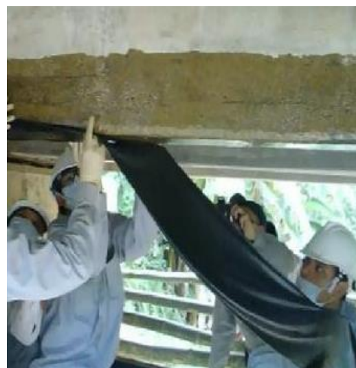
Gia cường, bảo vệ kết cấu (vật liệu dạng vải sợi)
